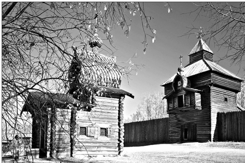
Илимская Казанская церковь и Спасская башня Илимского острога. Фото И. Бержинского, 2009 г.
