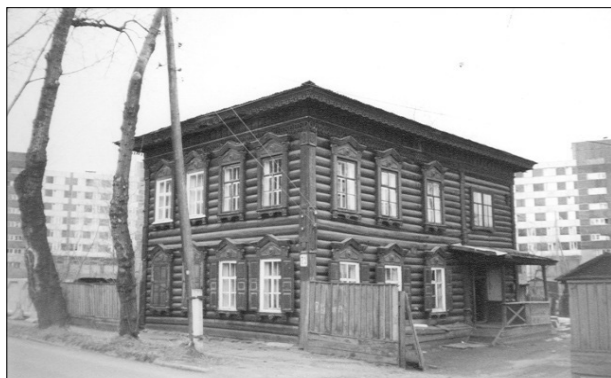
Ул. Красногвардейская, 25 – лестница включена в общий объем на дворовой части дома
