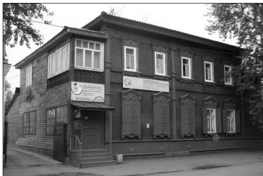
Ул. Декабрьских Событий, 62. Открытые галереи по обоим торцам жилого объема (на левой галерее остекление – позднее)
