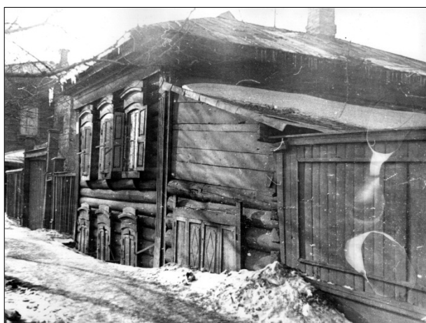
Илл. 2. Общий вид дома со стороны улицы.
