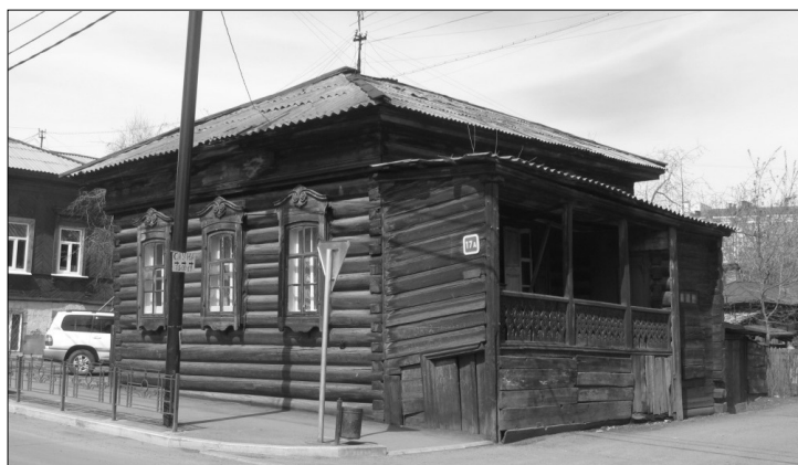
Илл. 14. Здание по ул. Грязнова, 17 – пример дома с галереей и лицевой «фальш-стеной», возведенными позднее самого дома при приспособлении его под аренду и раздельное использование этажей
