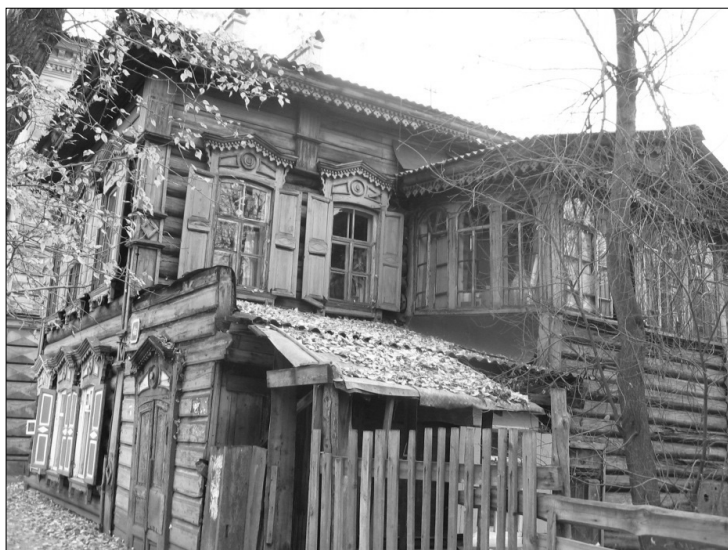
Ул. Чехова, 4. Общий вид со стороны улицы
