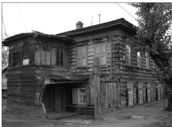
Ул. К. Либкнехта, 35. Вдоль бокового фасада устроен каменный брандмауэр
