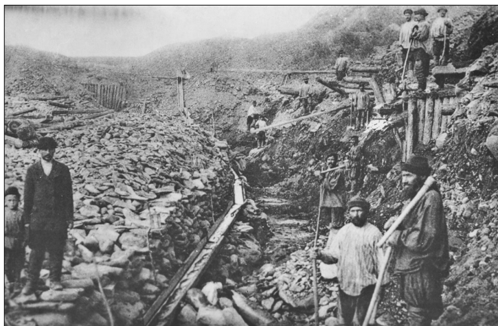
Промывка золотоносной породы на желобах. Начало XX в.
