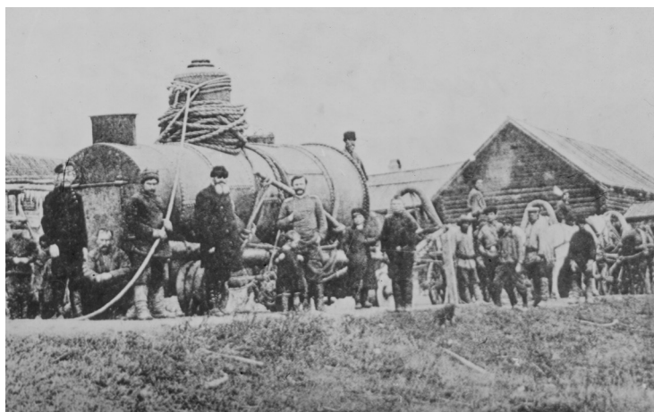
Перевозка котла для паровой машины. Начало XX в.
