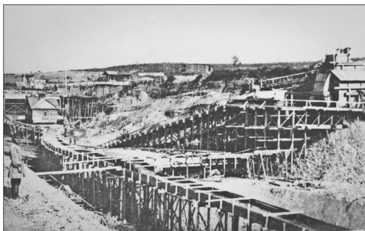
Желоба для подачи воды для промывки породы машинами
