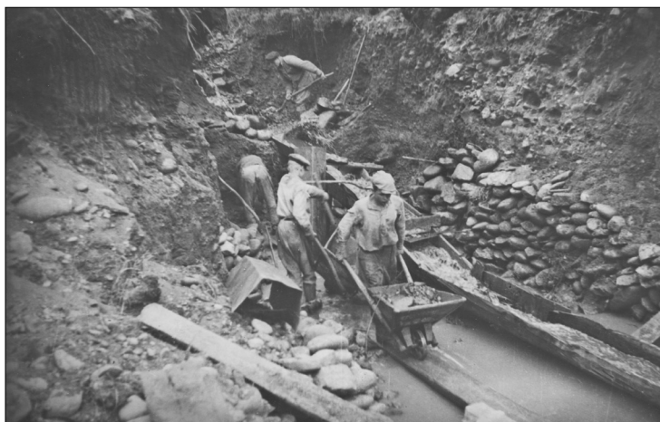
Промприбор. Отводка пустой породы. Фото В.Л. Тихонова, 1946 г.
