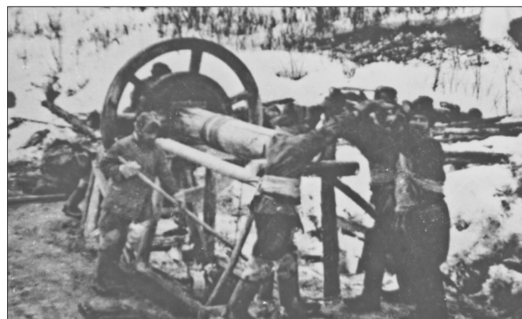
Подъем золотоносной породы из шурфа
