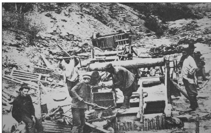
Добыча породы из шурфа
