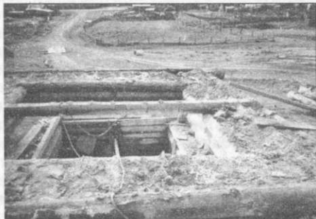
Реставрация дома, 1997г.
