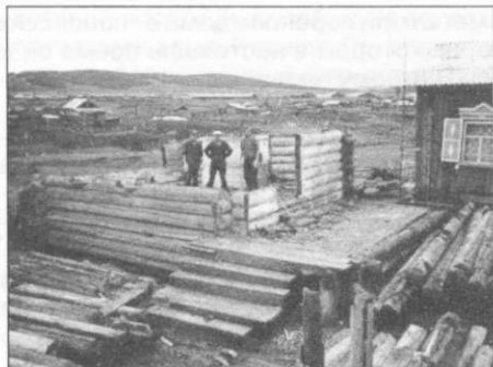
Реставрация дома, 1997г.
