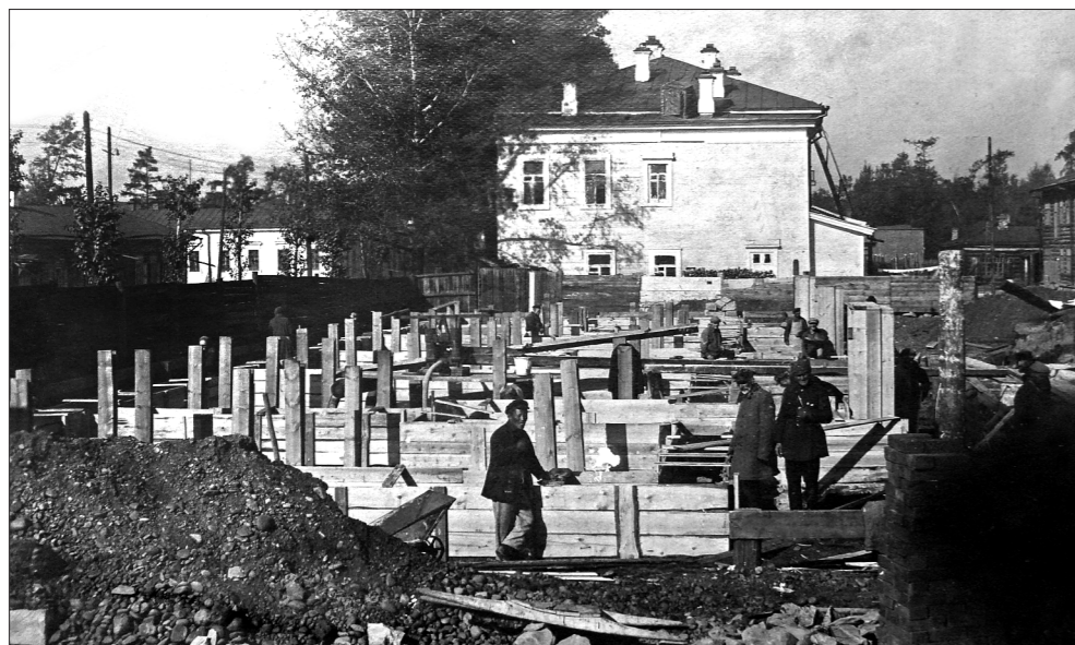
Ил. 32. Строительство двухэтажного шлакобетонного дома для специалистов метзавода им. В. В. Куйбышева. Фото 1931 г. На заднем плане восточный фасад дома губернатора. Веранда второго этажа зашита и приспособлена под жилье. Справа виднеется двухэтажный деревянный дом завода постройки 1930 г.
