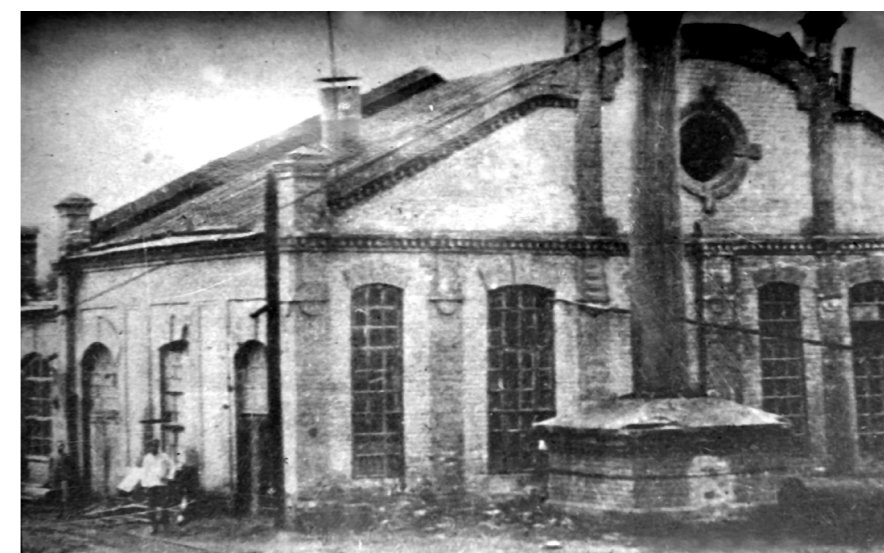
Ил. 12. Котельное и машинное отделение при обозной мастерской, после реконструкции – цех № 20. Музей ИЗТМ
