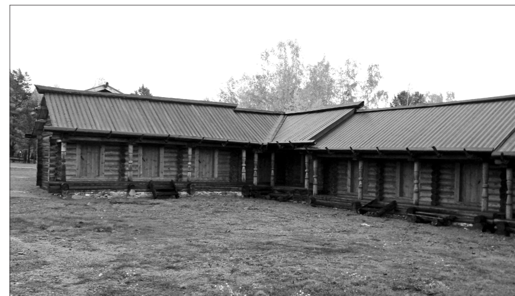
Комплекс зданий гостинного двора в музее «Тальцы». Фото О. Фроловой, 2015 г.
