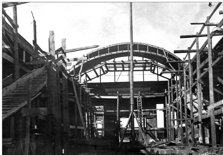
Ил. 30. Строительство чугунолитейного цеха. 1930 г. Музей ИЗТМ
