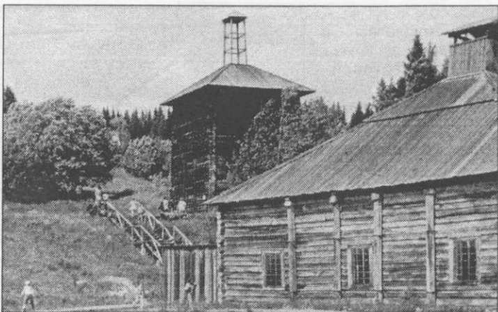
Фрагмент комплекса «Усть-Боровской солеваренный завод купца Рязанцева». 1880 г.
