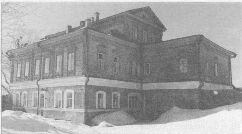
Здание конторы сользавода, 1884 г.
