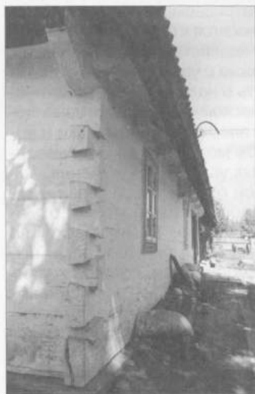
Примеры рубки углов и обработки консольных выпусков балок. Слева: Средний Пихтинск, дом Ю.М. Людвига. Фото И. Бержинского, 2004 г. Справа: иллюстрация из статьи Яна Гурака. Mościce Dolne (Польша)
