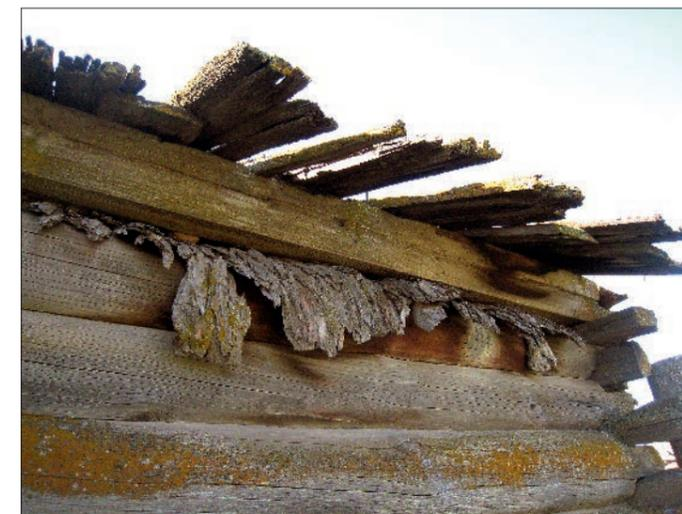
Фото 16. Трехслойное покрытие крыши юрты: жерди — кора — дерн. Сверху два слоя досок
