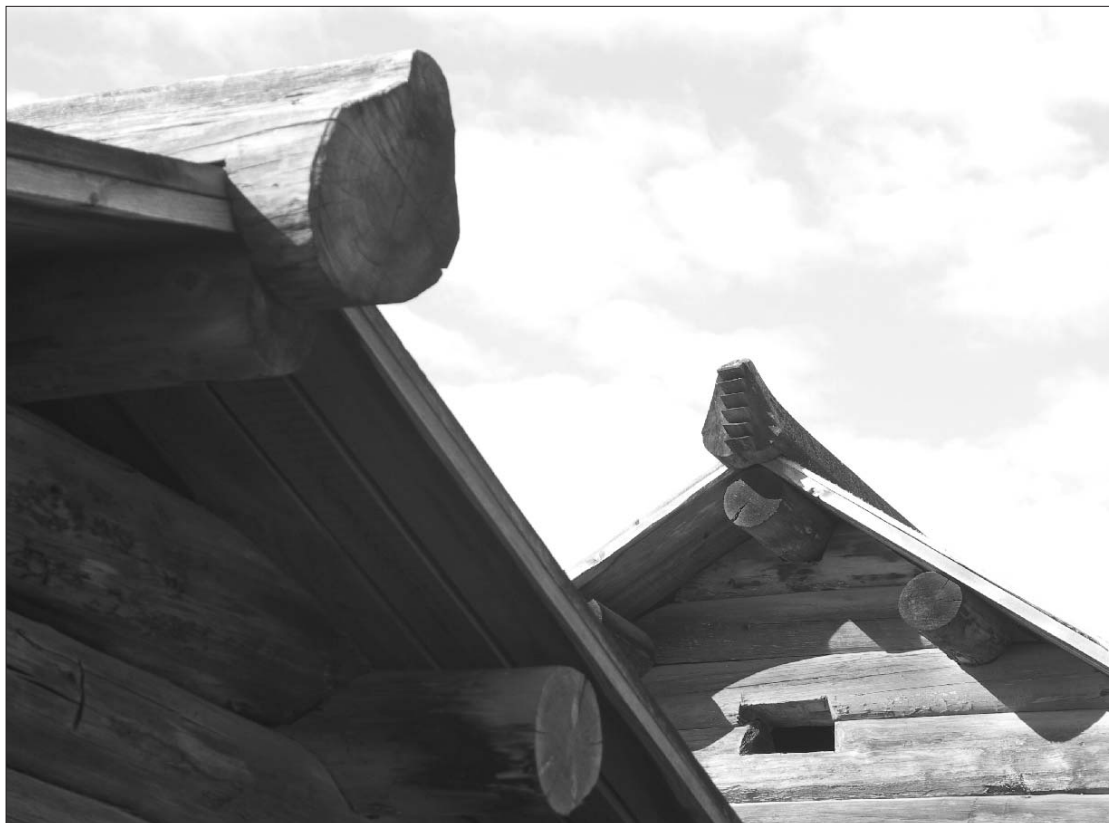
Коньки на постройках усадьбы Прокопьева, Фото В. Щербина. 2006 г.
